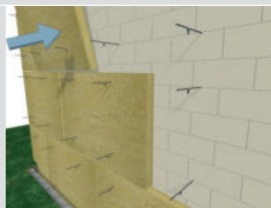
3. Fixer les panneaux jointivement contre la paroi intérieure au moyen de crochets d'ancrage avec rosace (min. 4 crochets par m<sup>2</sup>).
