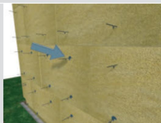
4. Monter la paroi extérieure du mur creux en évitant que les restes de ciment ne soient en contact avec l'isolant. Dans le cas de murs avec un remplissage partiel, prévoir une lame d'air de min. 10 mm.
